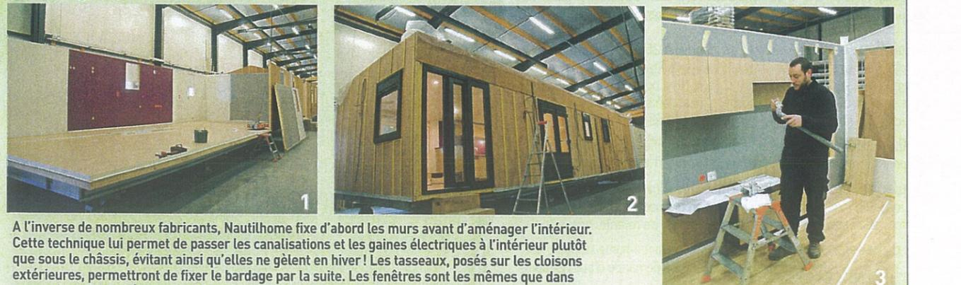
A l'inverse de nombreux fabricants, Nautilhome fixe d'abord les murs avant d'aménager l'intérieur. Cette technique lui permet de passer les canalisations et les gaines électriques à l'intérieur plutôt que sous le châssis, évitant ainsi qu'elles ne gèlent en hiver ! Les tasseaux, posés sur les cloisons extérieures, permettront de fixer le bardage par la suite. Les fenêtres sont les mêmes que dans une maison. Les aménageurs et le cuisiniste viennent ensuite poser les meubles avec précaution.
