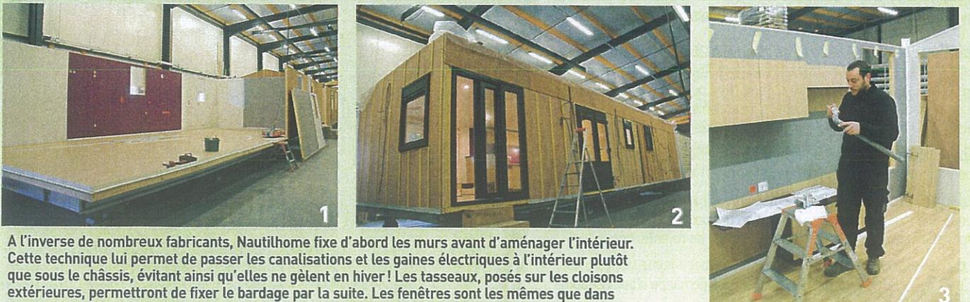
A l'inverse de nombreux fabricants, Nautilhome fixe d'abord les murs avant d'aménager l'intérieur. Cette technique lui permet de passer les canalisations et les gaines électriques à l'intérieur plutôt que sous le châssis, évitant ainsi qu'elles ne gèlent en hiver ! Les tasseaux, posés sur les cloisons extérieures, permettront de fixer le bardage par la suite. Les fenêtres sont les mêmes que dans une maison. Les aménageurs et le cuisiniste viennent ensuite poser les meubles avec précaution.
